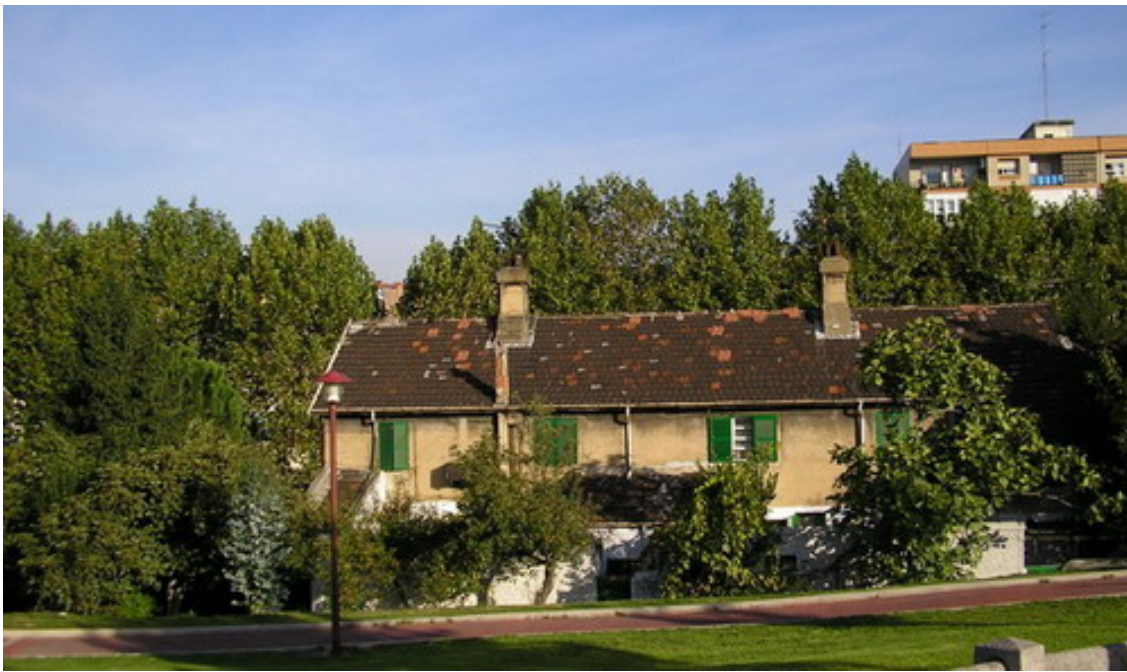
El chalet derribado en una imagen de 2005 (Coordenadas: (+43° 17' 20.00", -2° 58' 50.11") (43.288889, -2.980586)
